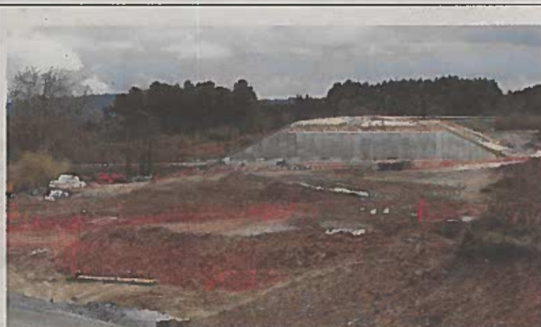
Obras del trazado de la A-56, en A Barrela.
