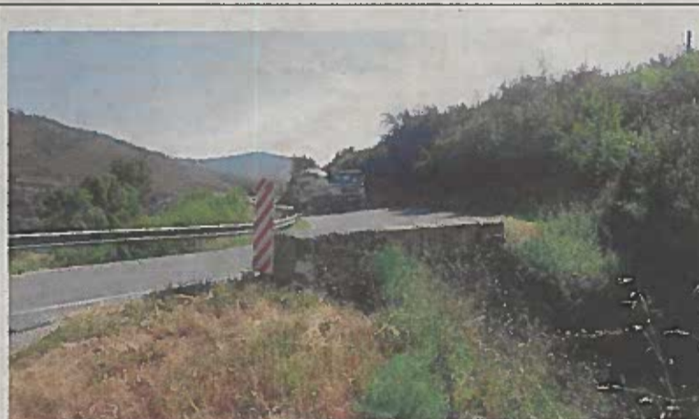
Tramo de la N-536, en Valdeorras.
